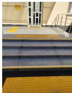
**5) перед перешкодами, що становлять небезпеку для осіб з порушенням зору, а також паралельно до сходів, перед і після сходового маршу розташована попереджуvalьна тактильна смуга\***
